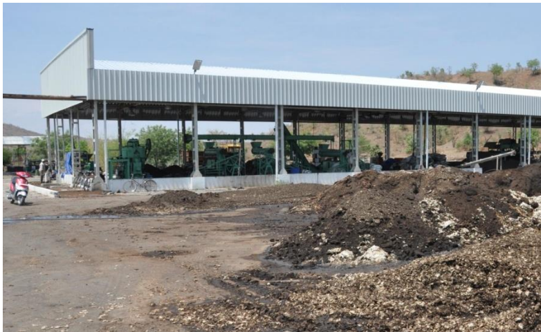
Die Kompostierungsanlage in Jalgaon
