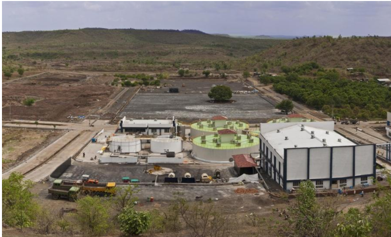
Die Biogasanlage während der Bauphase
