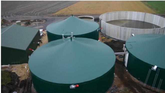
Das Biogas wird mit einem BHKW verstromt. Die gleichzeitig anfallende Abwärme wird für die Eigenversorgung der Prozesswärme und der Überschuss zur Trocknung von Brennholz in einem Trocknungscontainer verwertet. Durch die Nutzung der Wärme erhöht sich der Gesamtwirkungsgrad der Anlage, zusätzlich wird ein KWK-Bonus gewährt, welcher die Biogasanlage insgesamt nachhaltig wirtschaftlicher macht.
